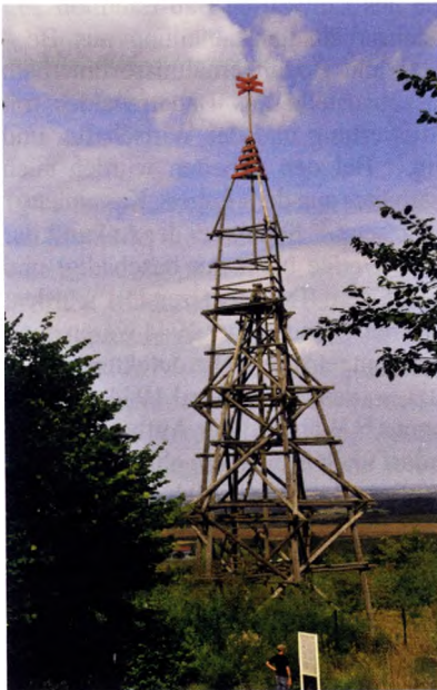
Nachbau eines standardisierten Vermessungsturm aus dem Jahre 1939 (Standort Freilichtmuseum Kommern) und Schemazeichnung der Spitze
