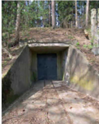
*Munitionshäuser gab es in der Größe zwischen 40 bis 180 m<sup>2</sup> in denen Pulver, Sprengstoff, Hülsen und fertige Munition gelagert wurden.*
